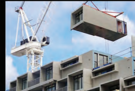
PPVC & PBU Beton Pracetak
