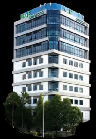
Kantor Pusat JOE Green Gedung AMAZANA Singapura
