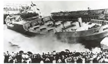
Peluncuran Kapal Berbahan Beton Ringan U.S.S. SELMA pada tahun 1919
