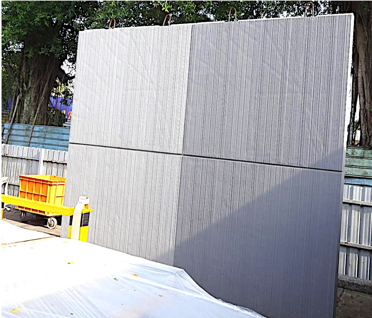
Fasad pracetak menggunakan Form-liner molding Bergelombang Menempati crane hours
