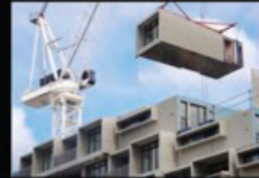
PPVC & PBU Beton Pracetak
