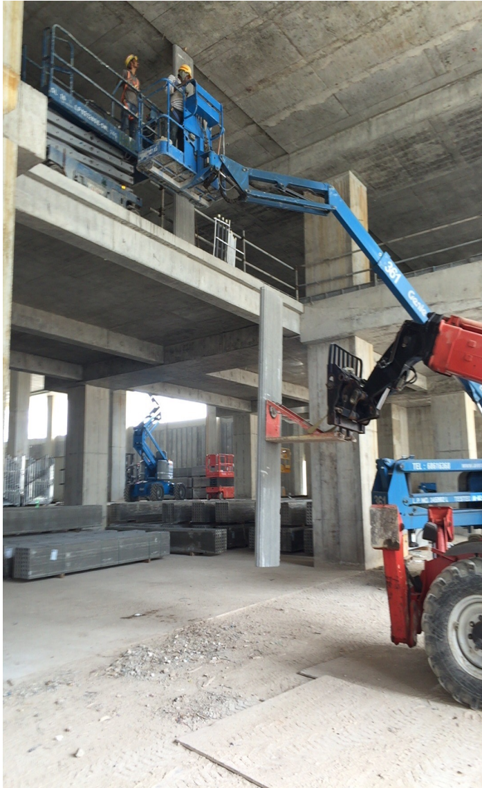
Menggunakan Forklift dan Scissor Lift untuk Pengangkatan dan Pemasangan
