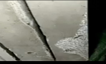
Joint retak dan kerosok
