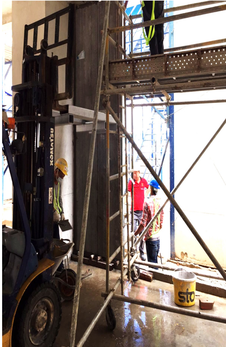
Menggunakan Forklift dan Lorry Crane untuk Pengangkatan dan Pemasangan
