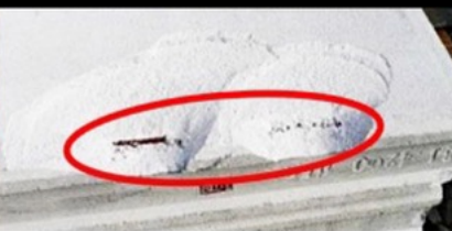
Berpori, korosi didalam BRC, dan Bending and tidak kuat
