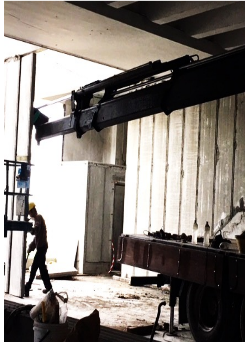
Menggunakan Forklift dan Lorry Crane untuk Pengangkatan dan Pemasangan
