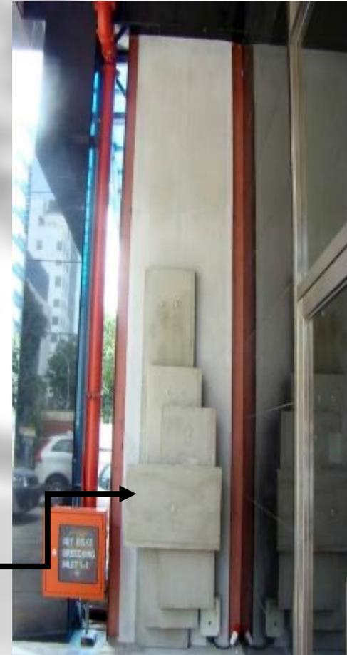
5.4m JOE 绿色混凝土面板，带脱脂涂层，在单个重力锚固上加载 650 千克
